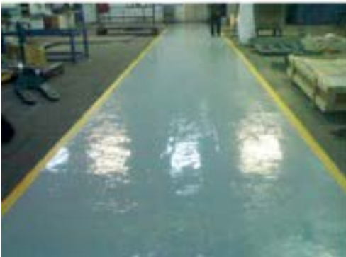
6 Epoxy SF 260 - ThyssenKrupp Jordan
